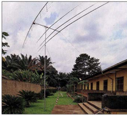
Zwei-Element-Fünfband-Yagi für die RTTY-Station
